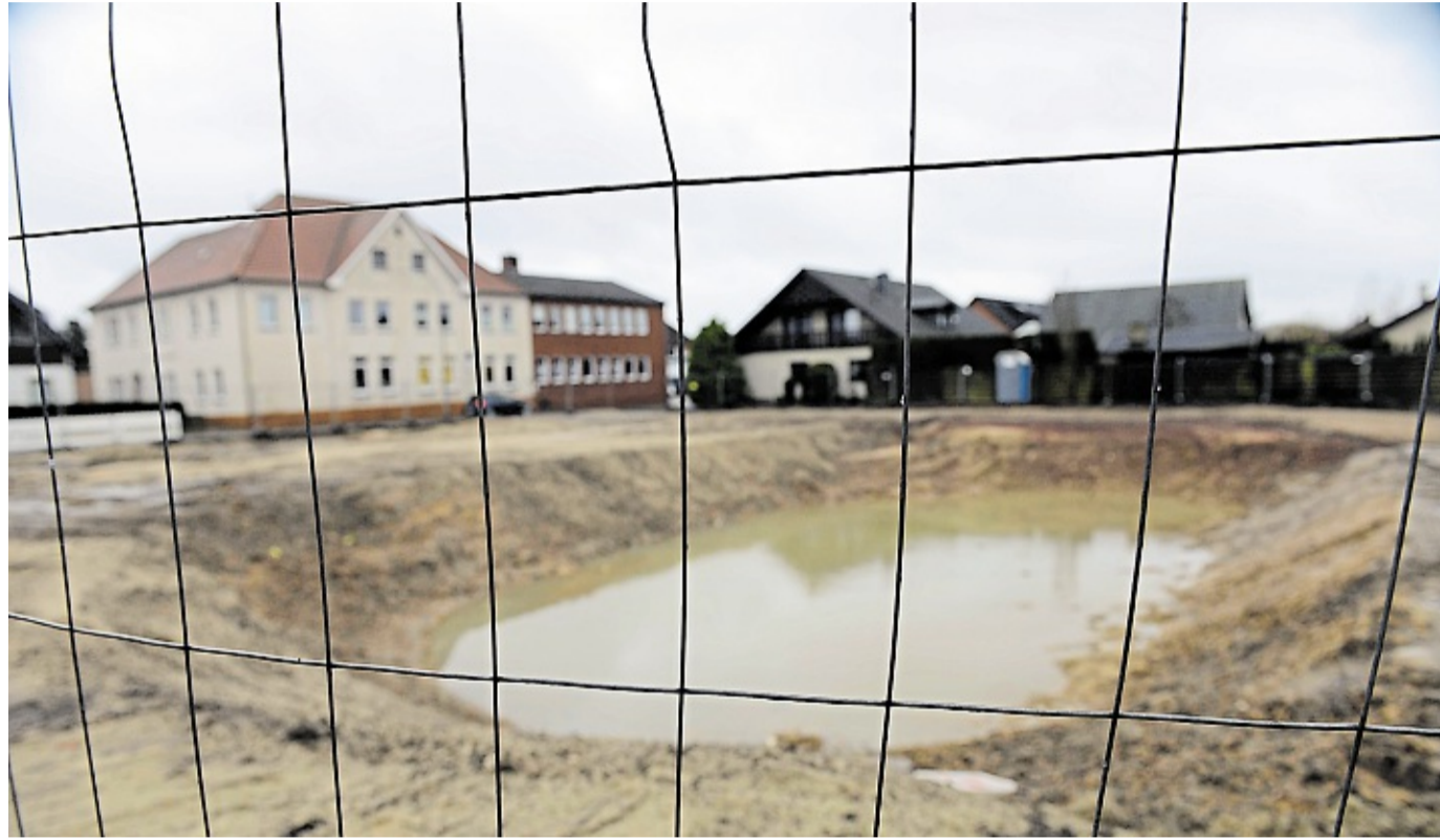
Nach dem Abriss des alten Verwaltungsgebäudes an der Alten Poststraße 5–7 plant die Samtgemeinde Neuenkirchen an dieser Stelle den Neubau des Rathauses. Foto: Christian Geers
