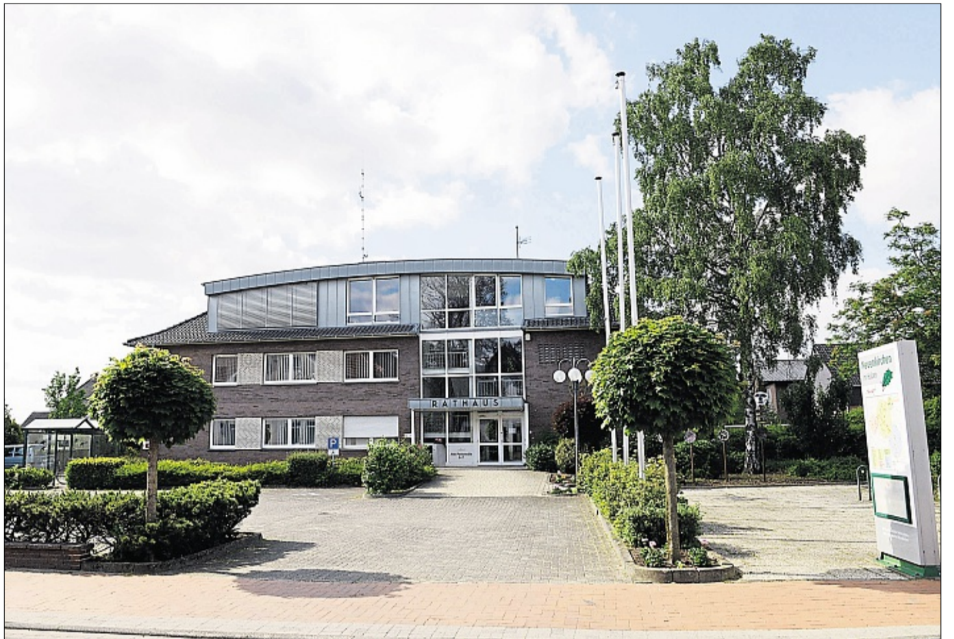
Das Grundstück an der Alten Poststraße ist groß genug für einen Neubau, der im vorderen und im hinteren Bereich platziert werden könnte. Außerdem könnte das bestehende Rathaus während der Bauzeit weitergenutzt werden. Foto: Christian Geers
